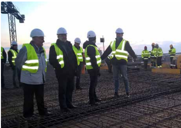
Wyjazd techniczno-szkoleniowy na budowę biurowca Centrum Dystrybucyjnego Grupy Neuca w Toruniu, 28 listopada 2018 r.
