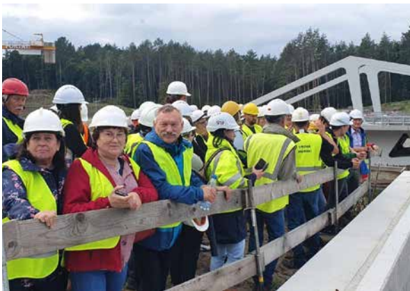
Wyjazd techniczny dla członków KUP OIIB na budowę przekopu Mierzei Wiślanej, 17-18 września 2021 r.
