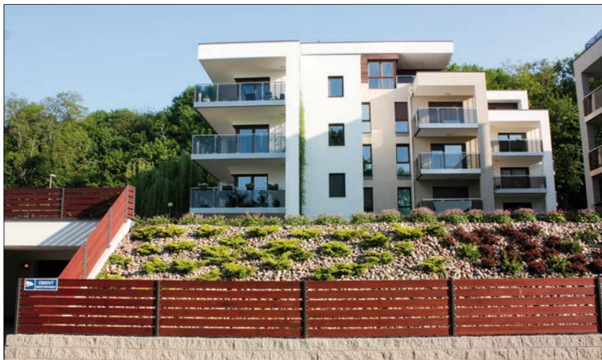
■ Kompleks budynków Calor przy ul. Winnica 41-43 emanuje elegancją i świeżością formy
