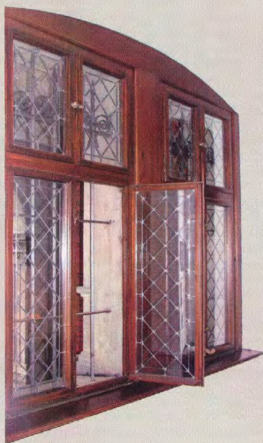
16. Okno po restauracji w pałacu w Pławniowicach, z jednoczesną wymianą szyby pojedynczej na zespoloną, wewnątrz szyby zespolonej błona szklana z podziałem romboidalnym A – okno w całości, B – fragment skrzydła okiennego – strzałka wskazuje listewkę mocującą szyby zespolone
