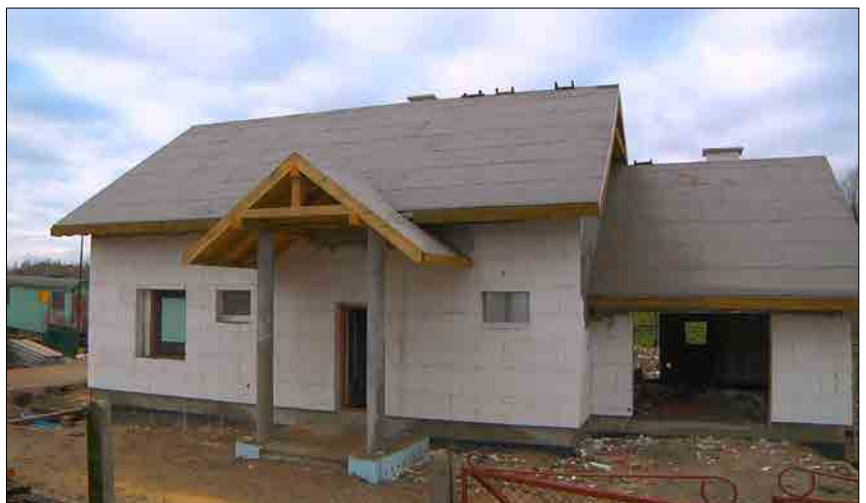
■ Styropianowe szalunki pozwalają m.in. zniwelować mostki termiczne w konstrukcjach budynków
