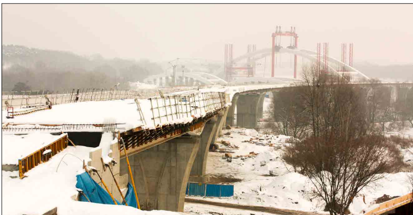
■ Gotowe przęsło czeka na wiosnę
