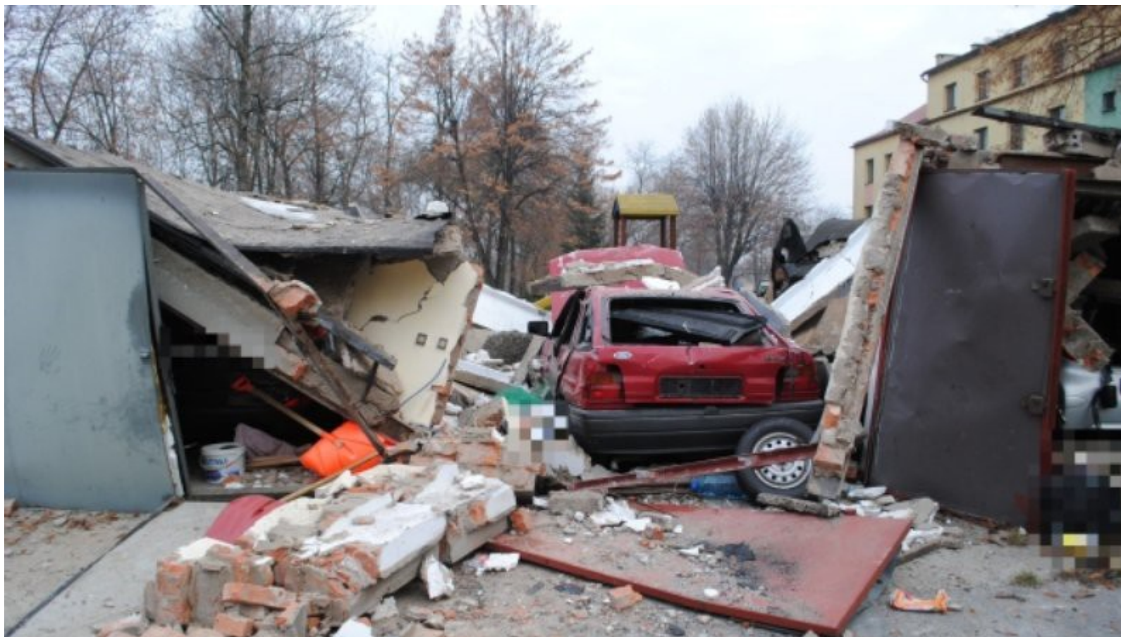
KŁOBUCK Eksplozja instalacji gazowej LPG
