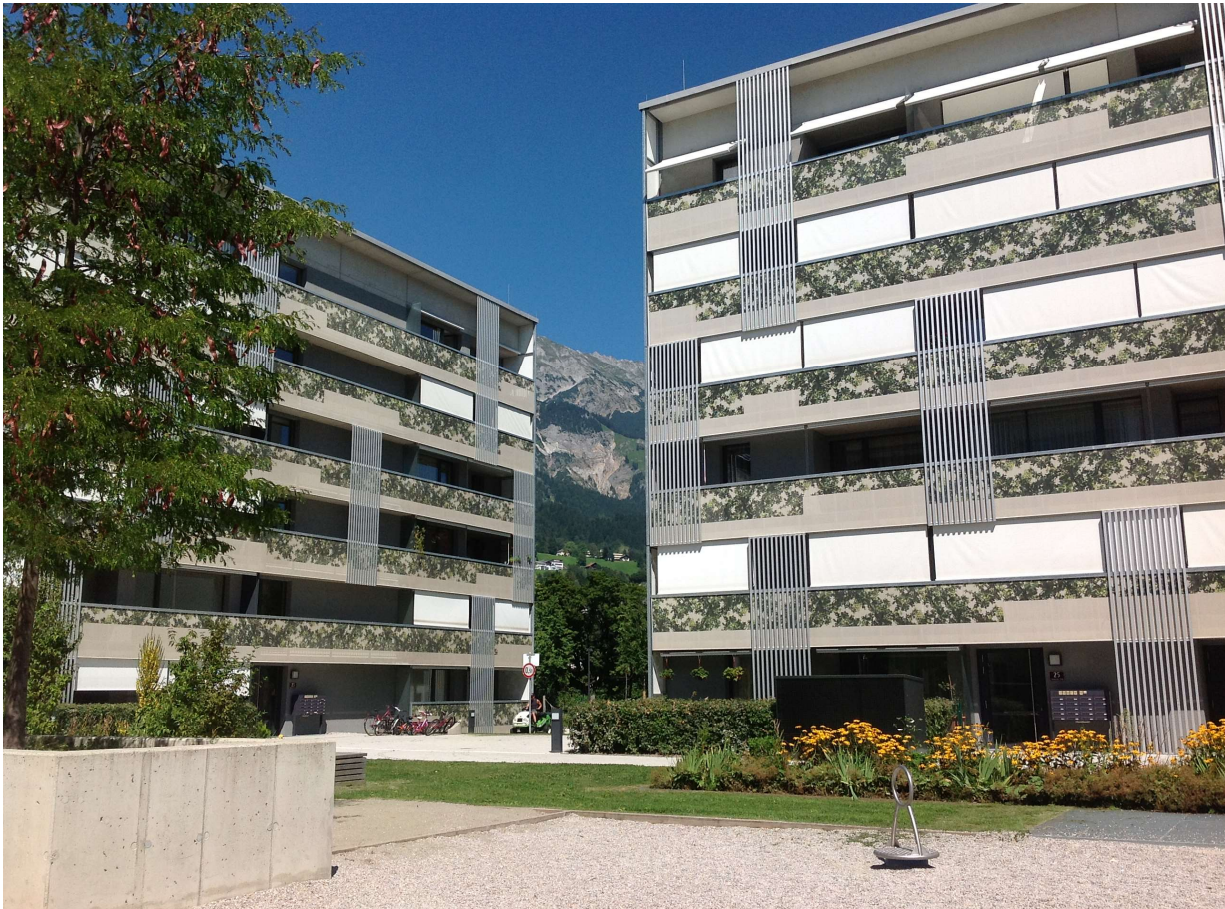
Osiedle budynków pasywnych – budynki wielorodzinne z mieszkaniami socjalnym
