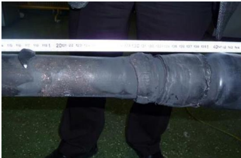
9. Widok powierzchni kabla pod stożkiem sterującym głowicy po przeciwnej stronie miejsca przebicia (rys.6)
