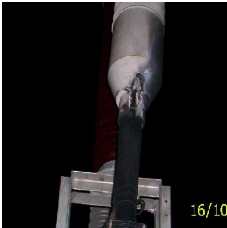
5. Widok głowicy po przebiciu
